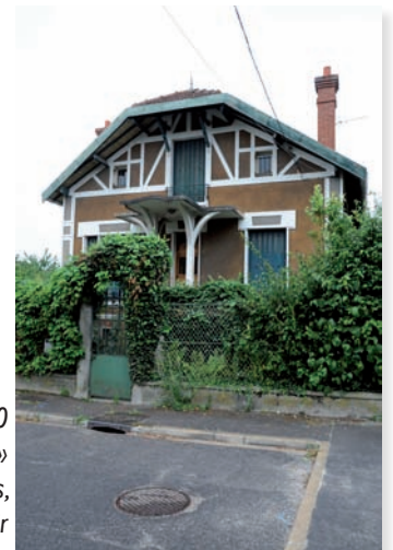
Pavillon années 1930 d'inspiration «basque» avec faux-colombages, 19 rue du Tir
