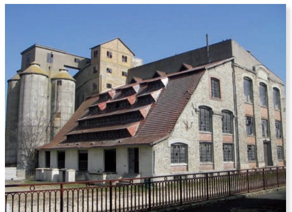
Anciens moulins Hutteau, 20/22 rue Lavoisier
