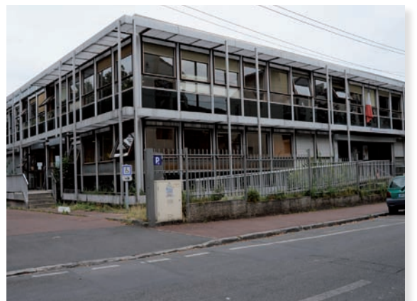
Centre des Finances Publiques, 75 rue Feray
